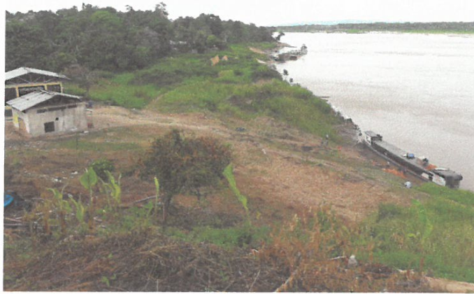
FOTO N° 08 : LLEGADA DE MATERIALES Y EQUIPO A PIE DE OBRA
