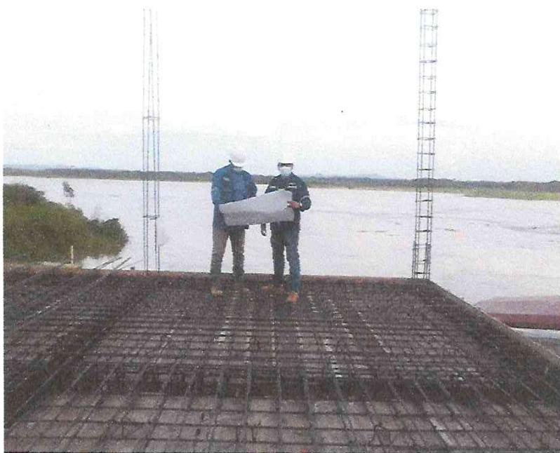
VERIFICACION DE ACERO EN LOSA MACISA SUPERVISION Y RESIDENTE
