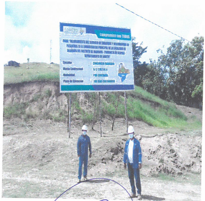
SUPERVISOR Y RESIDENTE EN VERIFICACION DE CARTEL DE OBRA.
