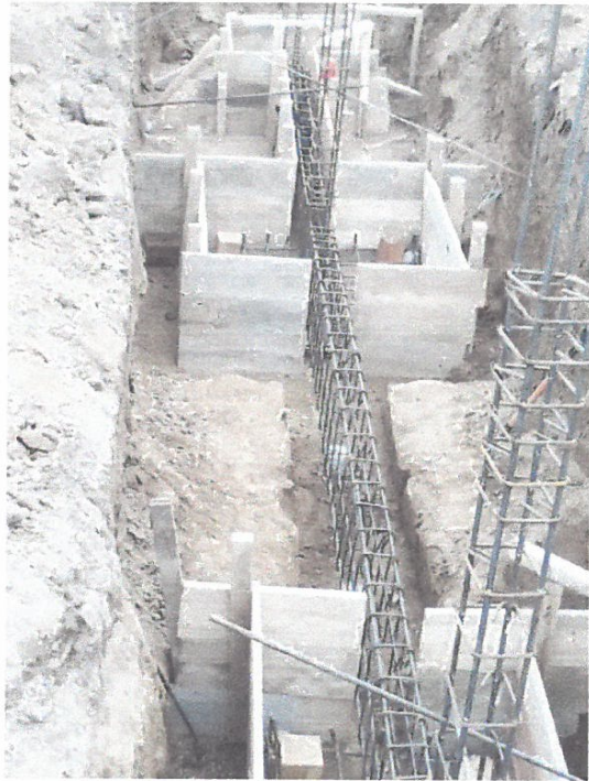
EN LA IMAGEN MUESTRA LA COLOCACION DE ACERO EN ZAPATAS Y VIGAS DE CIMENTACION.
