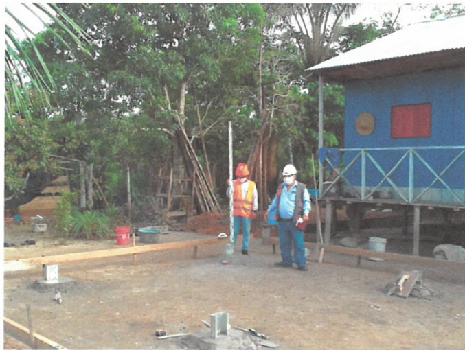
FOTO N° 05 : TRAZO Y REPLANTEO EN ZONA A EDIFICAR.
