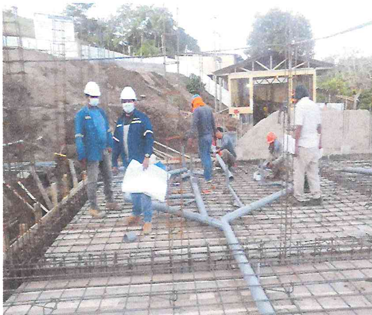
VERIFICACION DE INSTALACIONES SANITARIAS EN MODULO DE ADMINISTRACION VERIFICADO POR EL SUPERVISOR Y RESIDENTE.
