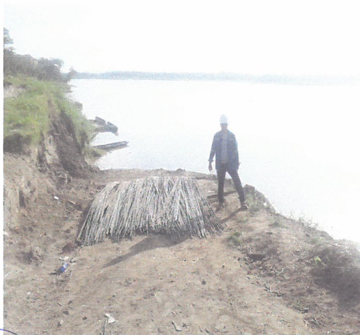
EN LA IMAGEN SE MUESTRA LA LLEGADA DEL ACERO.
