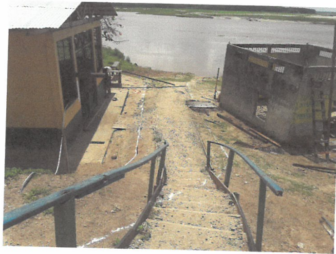
FOTO N° 10 : DEMOLICION DE ESTRUCTURAS COLINDANTE A LA OBRA.
