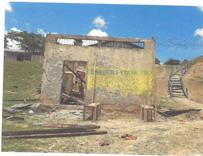
FOTO N° 11 : DEMOLICION DE ME MUROS EN ESTRUCTURAS COLINDANTES A LA OBRA
