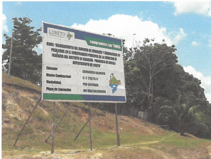
FOTO N° 01 : SE APRECIA LA COLOCACION DE CARTEL DE OBRA.
