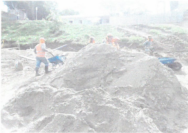
AGREGADO EN OBRA
