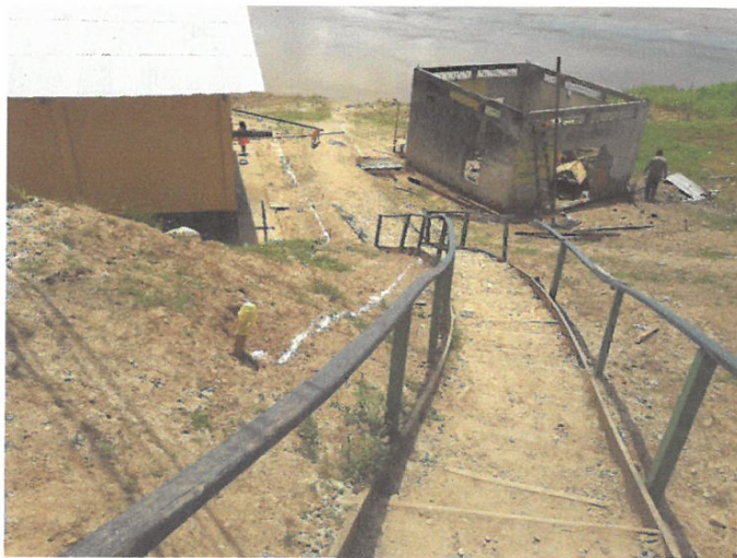
FOTO N° 09 : TRAZO Y REPLANTEO PRELIMINAR.
