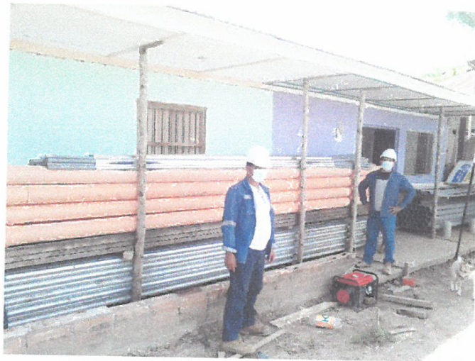
SUPERVISOR Y RESIDENTE EN INSPECCION DE MATERIAL EN OBRA.
